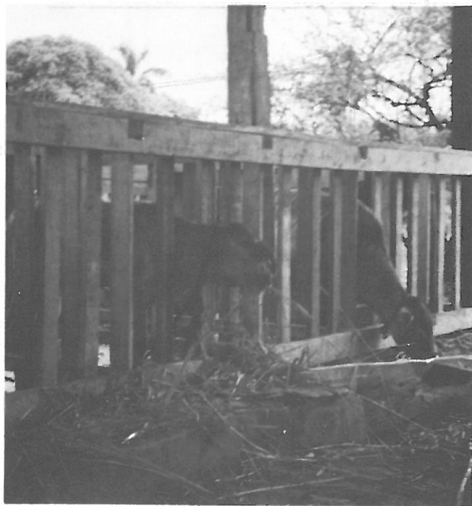
Figuur 53. Individuele kalverboxen op betonnen vloer en met houten wanden.
